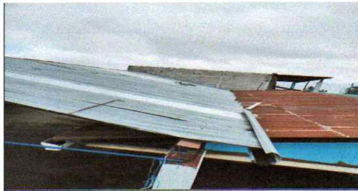
Foto 5: Sustitución de canal de pvc
