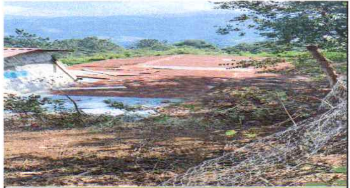
Foto 4: Sustitución de capote de lámina para lámina troquelada
