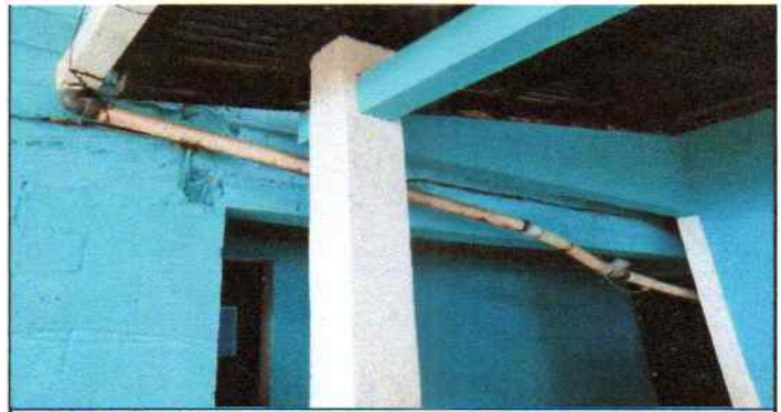
Foto 6: Sustitución de canal de pvc
